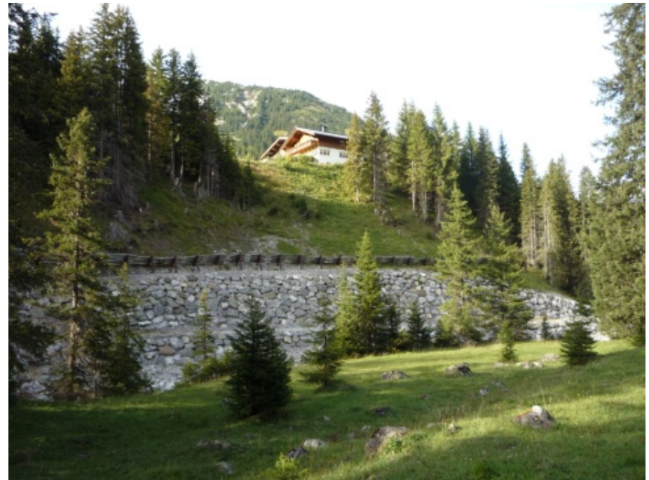
Situation heute, Wildbachverbau + Hangsicherung Fotos: N. Gebbeken
