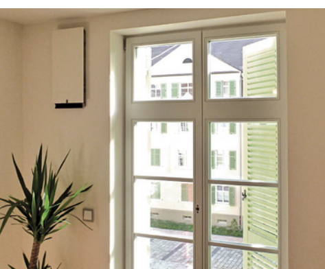
Wandintegriertes Lüftungsgerät
