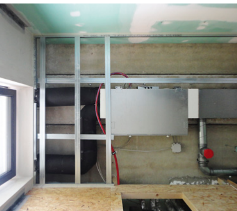
Gerät und Verteilung unter der Decke
