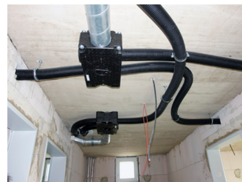
Sternförmige Erschließung über schallgedämmte Verteilboxen
