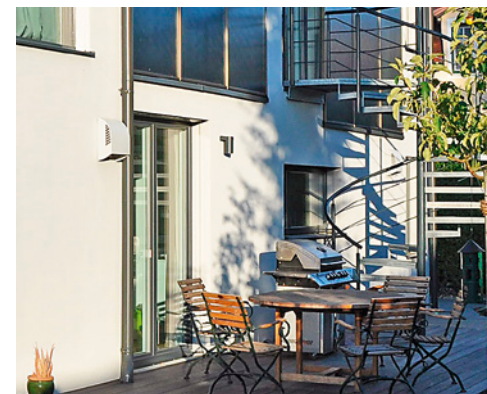
Außenluftelemente in der Fassade
