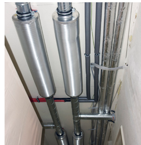
Wickelfalzrohr mit integrierten Schalldämpfern
