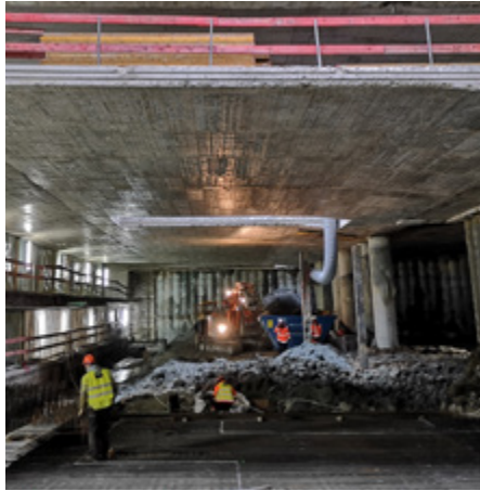
Bau von 520 Tiefgaragen-Stellplätze auf 3 Ebenen.
